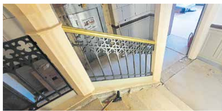
Das fertige Geländer im Treppenhaus des Rathauses von Weimar. Zuerst wurde die historische Zaunanlage am Computer digitalisiert. Foto: Tino Blaurock (l.)/BTZ (r.)
