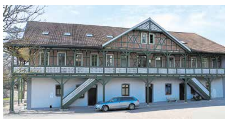
Das Schweizer Haus wird zum Verwaltungsgebäude umgebaut. Foto: HWK
