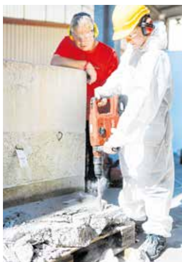
So fühlt sich das Bauhandwerk an: Voll ausgestattet konnten die Jugendlichen hämmern, bohren und sägen wie die Profis.
