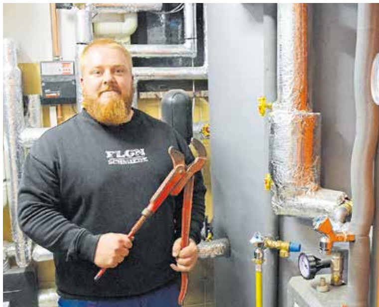
Installateur- und Heizungsbauermeister Michael Schilling hat seinen Beruf fest im Griff. Foto: HWK Südthüringen/Birgit Schunk
